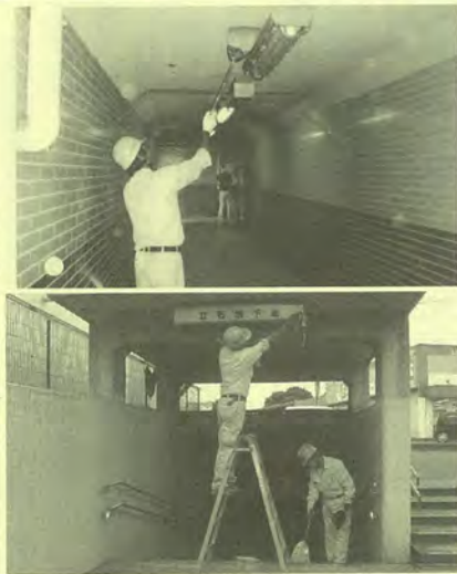
白河支部の作業状況
