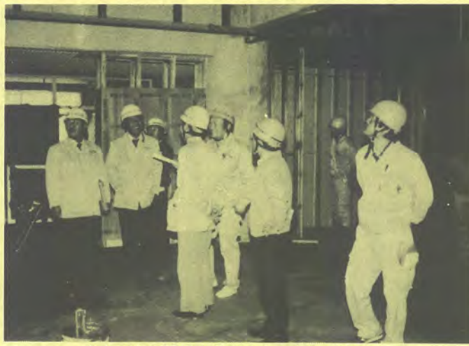
市立三中の現場を見てまわる新田支部長ら
