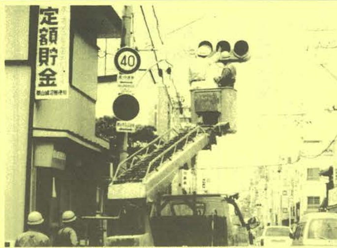
郡山合同庁舎前での作業(郡山支部)
