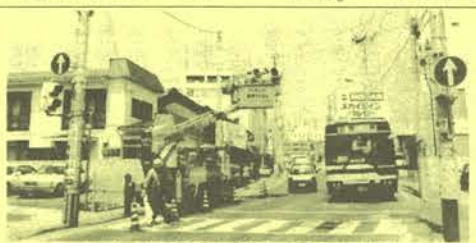
福島支部の作業(旧4号国道)
