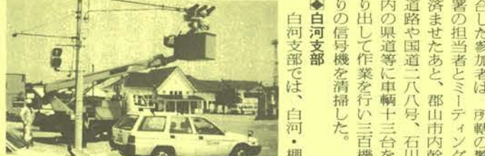
白河支部の作業(白河駅前)
