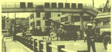
郡山支部の作業(石川町地内)
