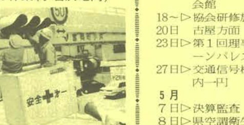
相双支部の作業(富岡町地内)
