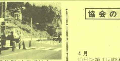
いわき支部の作業(小名浜地内)
