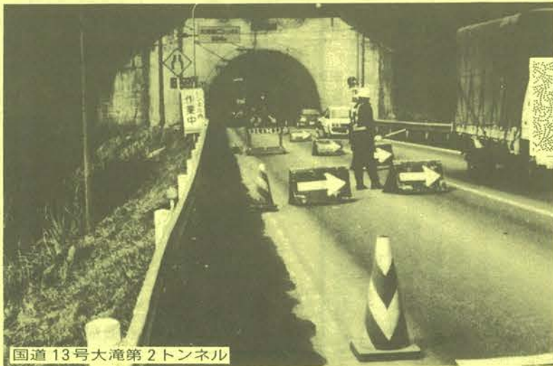
国道13号大滝第2トンネル
