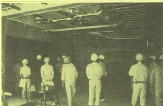
電気室周辺で配線を視察する参加者
