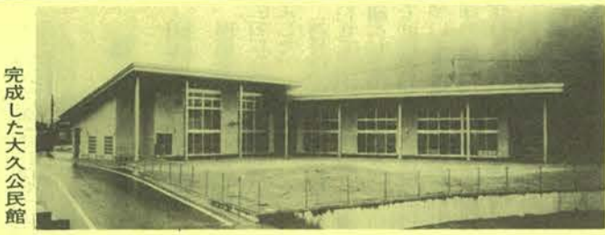
完成した大久公民館 あり、そのグレー色は周囲の建物、外壁がグレー色で
